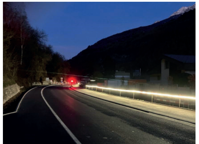
Baustelle Bitsch VS
